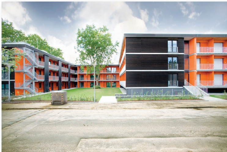
Das Studentenwohnhaus Eastsite
